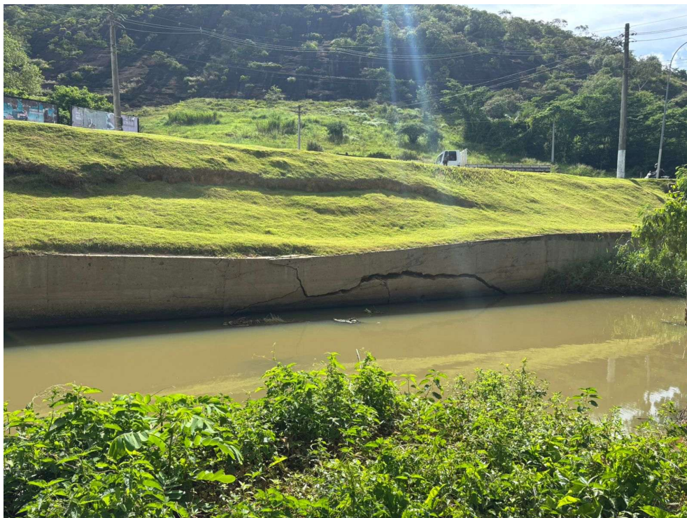
Figura 2: Vista da área onde será construído muro de contenção.
