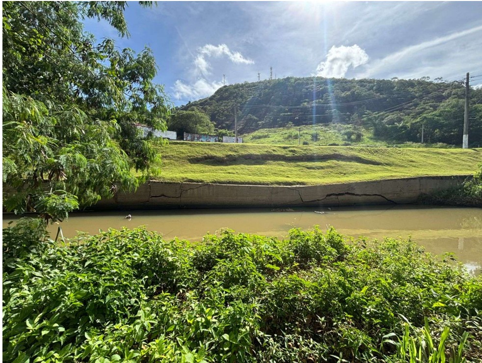
Figura 3: Vista da área onde será construído muro de contenção.
