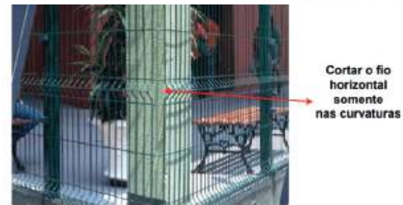
DETALHE 3 - CURVA DE PAINEL
